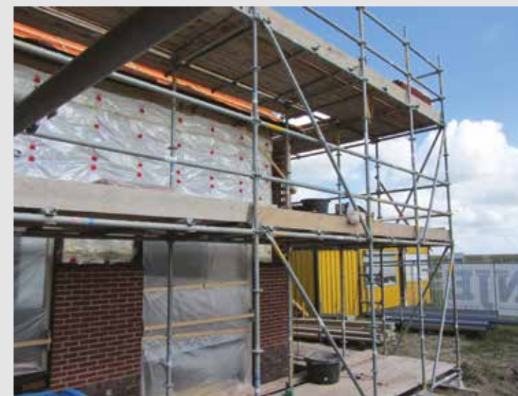
Spouwisolatie bij nieuwbouwwoningen
