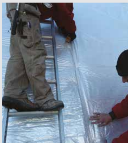
Banen onderling vastzetten met tape
